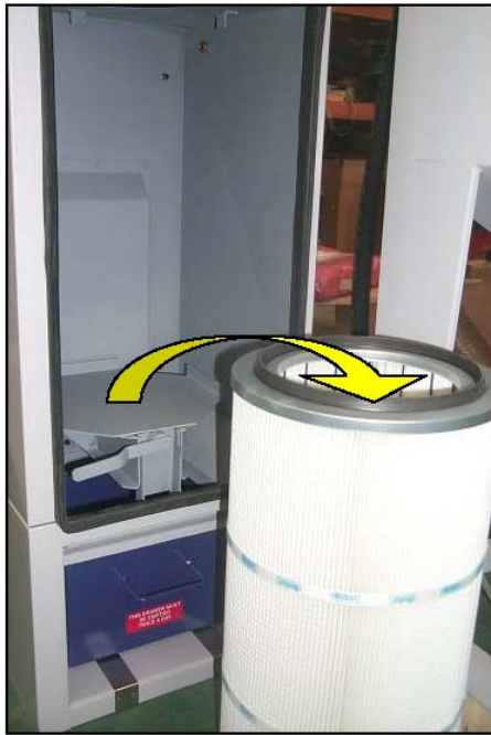
Рисунок 15: Удаление патрона фильтра (С400 МК4)
