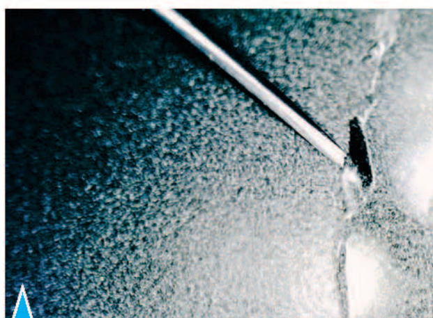
9.10.10. Отслаивание двух слоев лакокрасочного покрытия
